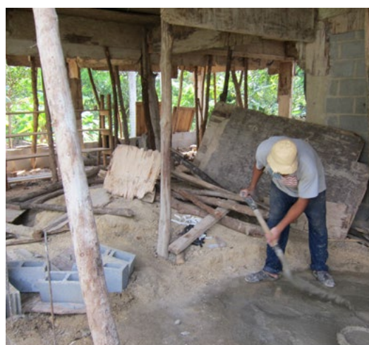
Der Rohbau kurz vor seinem Abschluss
